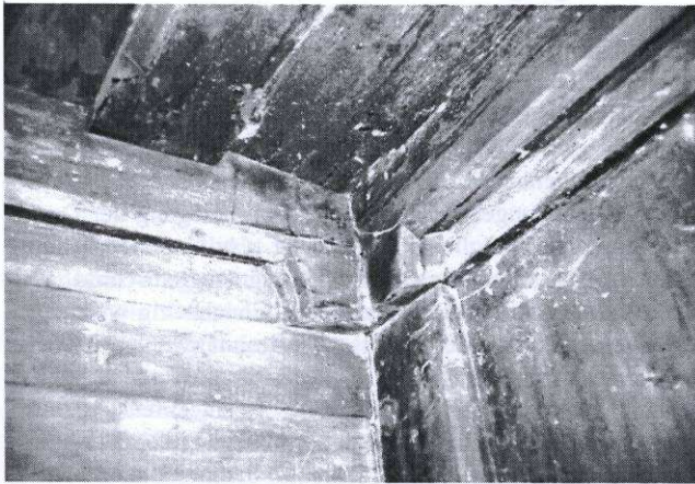
Abb. 3: Schloß Hanfelden. Eckverbindung mit Deckenrahmen und Steher in der Südostseite der großen Blockwerkkammer. (Foto: M. AIGNER).
