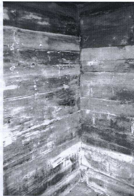
Abb. 4: Schloß Hanfelden. Eckverbindung ohne Ecksteher an der Trennwand der beiden Kammern. (Foto: M. AIGNER).
