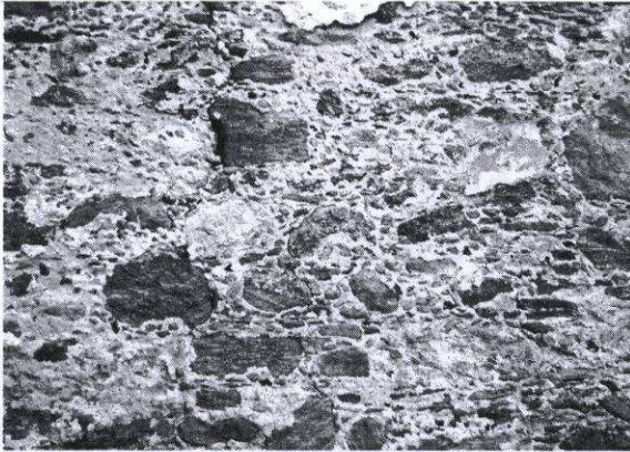
Abb. 1: Schloß Hanfelden. Mauerwerk Westtrakt. (Foto: M. AIGNER).
