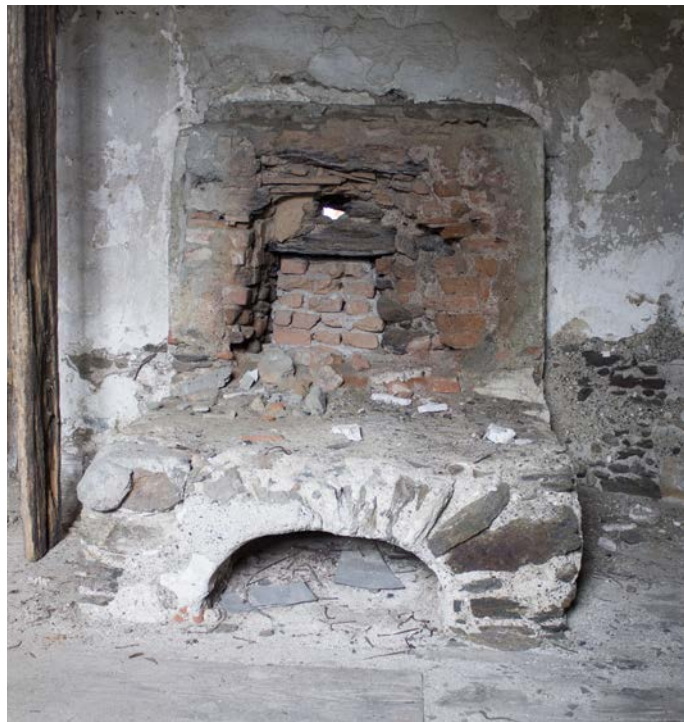
Abb. 13: Vorderseite eines Hinterladerkachelofens in Schloss Hanfelden mit ausgemauertem Steinsockel (Foto: I.Winkelbauer 2018)
