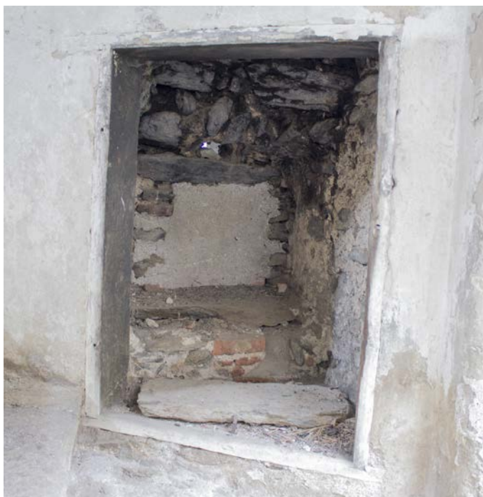
Abb. 14 Rückseite des Kachelofens. Die Beschickung erfolgte vom Stiegenhaus aus (Foto: I. Winkelbauer 2018)
