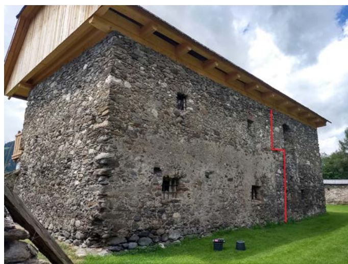
Abb. 9: Ostseite des Nebengebäudes mit rot markierter Baufuge (Foto: Cl. Theune 2018)
